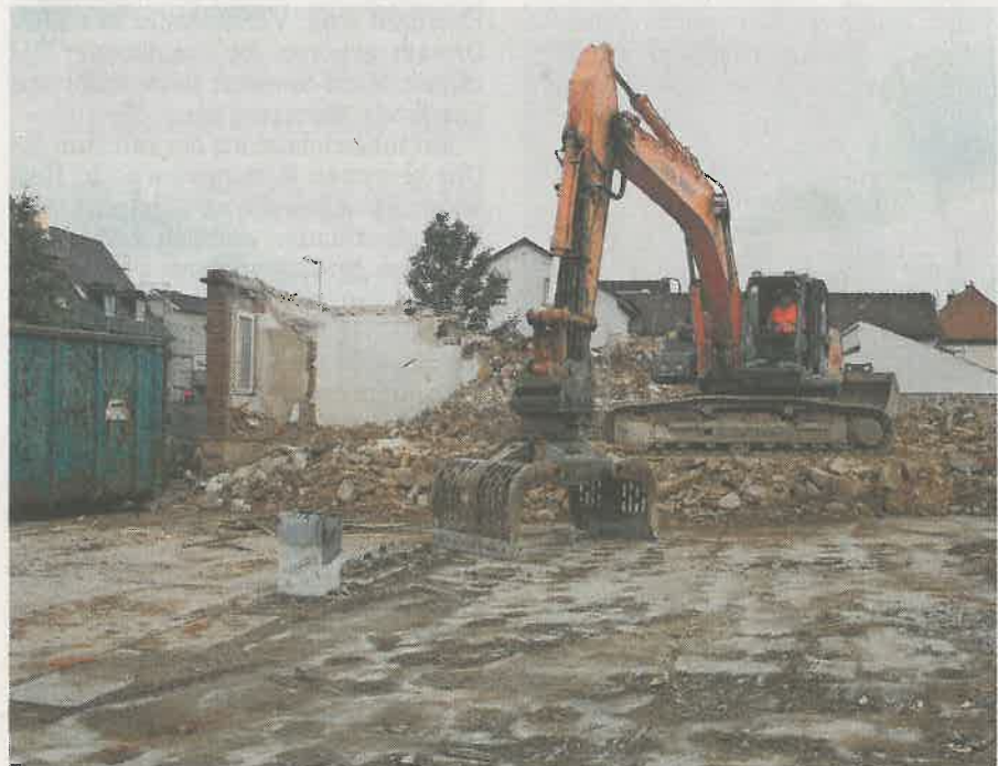
Im Juli 2010 rollten die Bagger an und machten das Backsteinhaus neben der einstigen Aral-Tankstelle platt. Archivfoto: Christian Weyer
