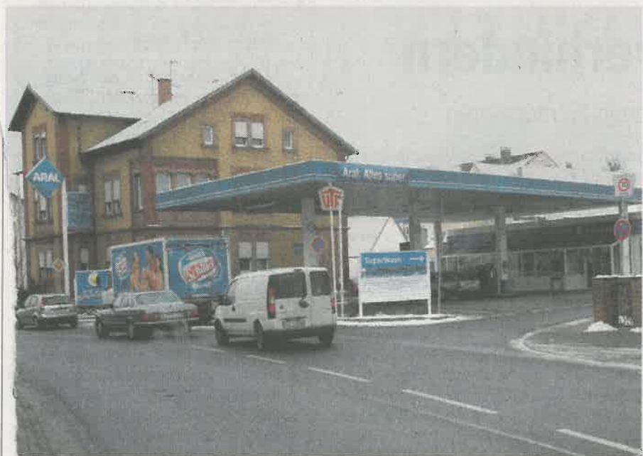
Die Aral-Tankstelle wurde im Januar 2010 geschlossen und dann abgerissen, wie auch das nachbarte Backsteinhaus. Archivfoto: Gunter Fritsch
